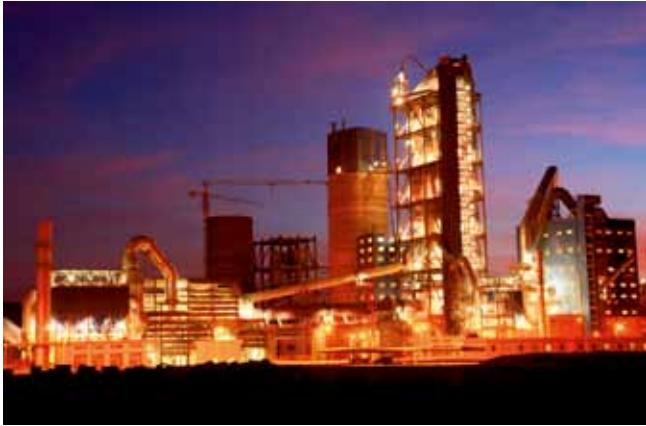
沙特RCC二期日产5000吨水泥生产线总承包项目
