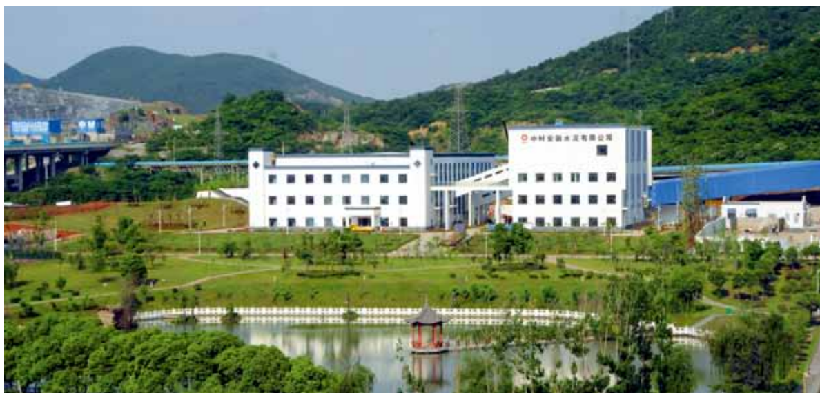
在安徽巢湖利用水泥窑无害化协同处置垃圾项目
