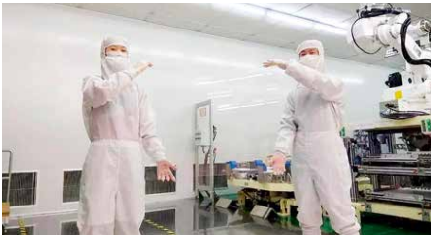
浮法高世代TFT-LCD玻璃基板生产线
