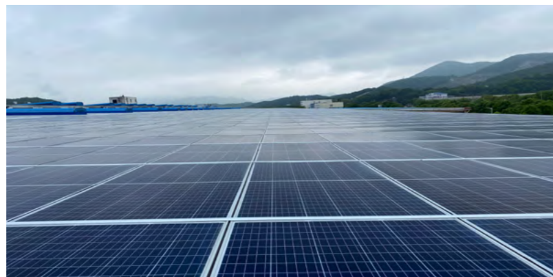
宁波北新光伏工厂
