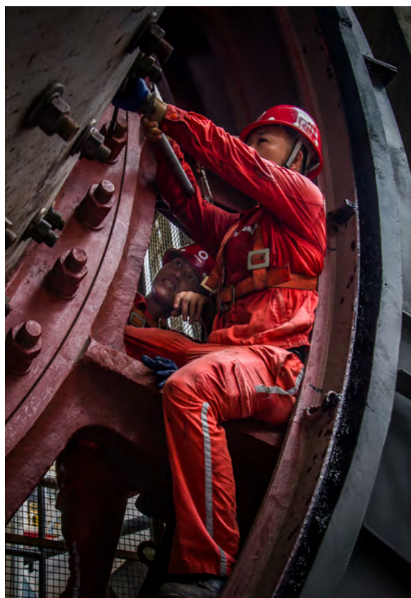
中材天山（云浮）水泥有限公司现场检修
