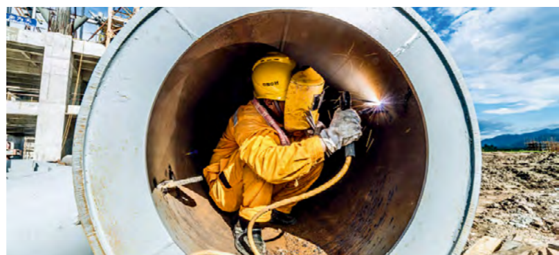
印尼北苏海螺一期项目现场
