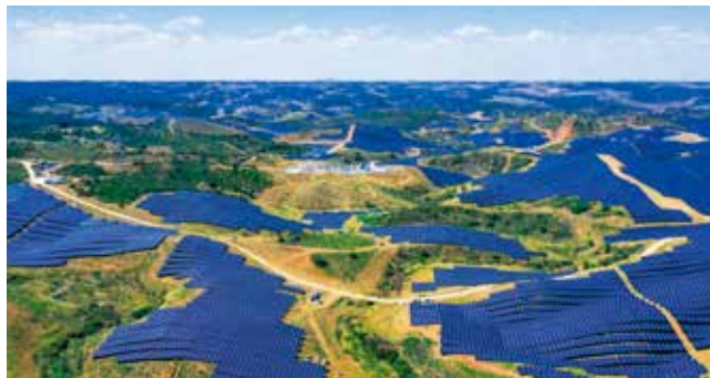
欧洲单体装机容量最大的光伏电站
