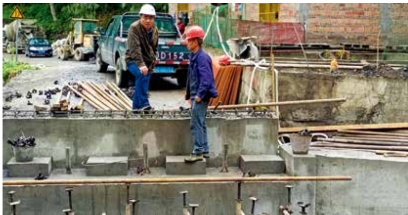
集团帮扶项目现场安全进度质量检查
